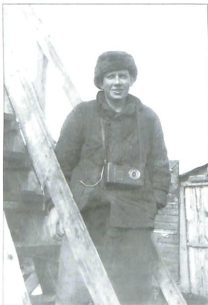
1965 г. На демонтаже буровой Р-1 Самотлор. Виктор Федотов – слесарь Мегионской НРЭ.
