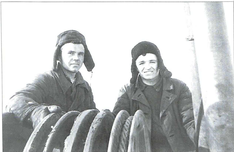
1962 г. Оснастка талевой системы на скважине Р-80 Усть-Бальжской. На высоте 42 метра помощники бурильщика, молодые специалисты – выпускники Пермского нефтяного техникума: Владимир Соловьев (справа) и Дмитрий Буйлов.
