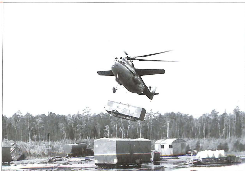
1979 г. Переброска вагон-домов и бурового оборудования вертолетом «Ми-6» на Холмогорском месторождении.
