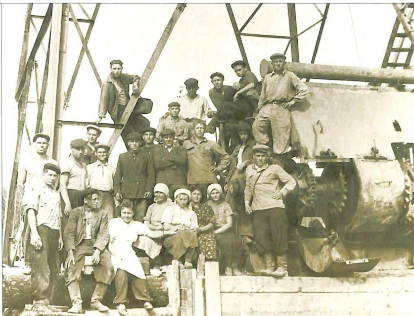
1958 г., п. Локосово. Бригада монтажников Геннадия Зевакина на строительстве буровой Р-31.
