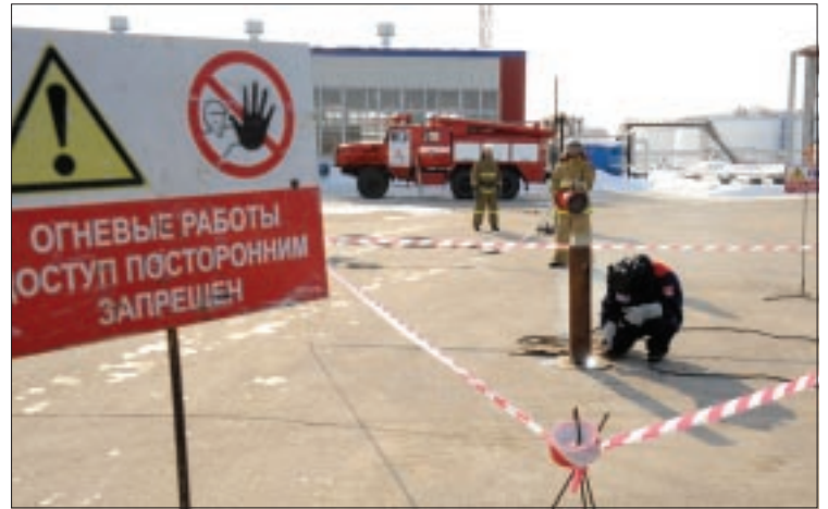
На опасном производственном объекте, как ЦППН-1 Ватинского НГДУ, дополнительные меры безопасности при проведении сварочных работ обеспечивает пожарный расчет
