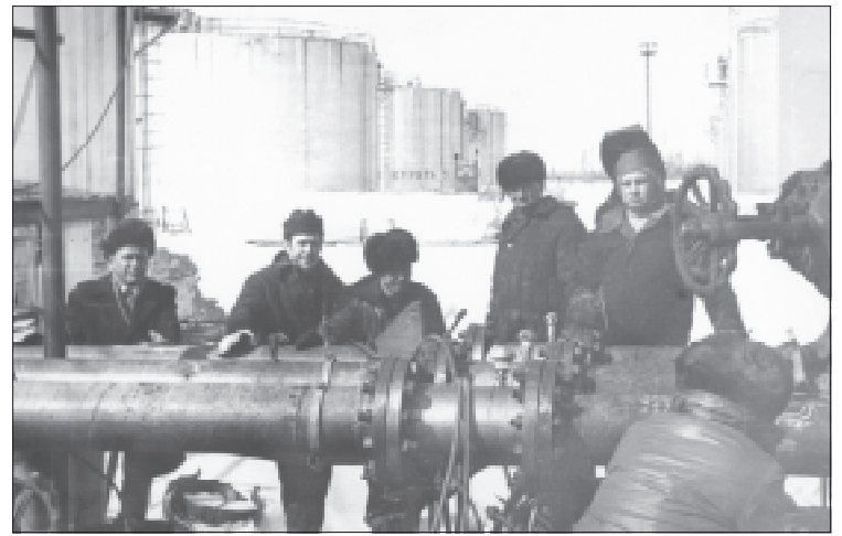
В.Н. Квасов вместе с коллегами проводит обвязку счетчиков коммерческого узла учета ЦППН-1 ВНГДУ
