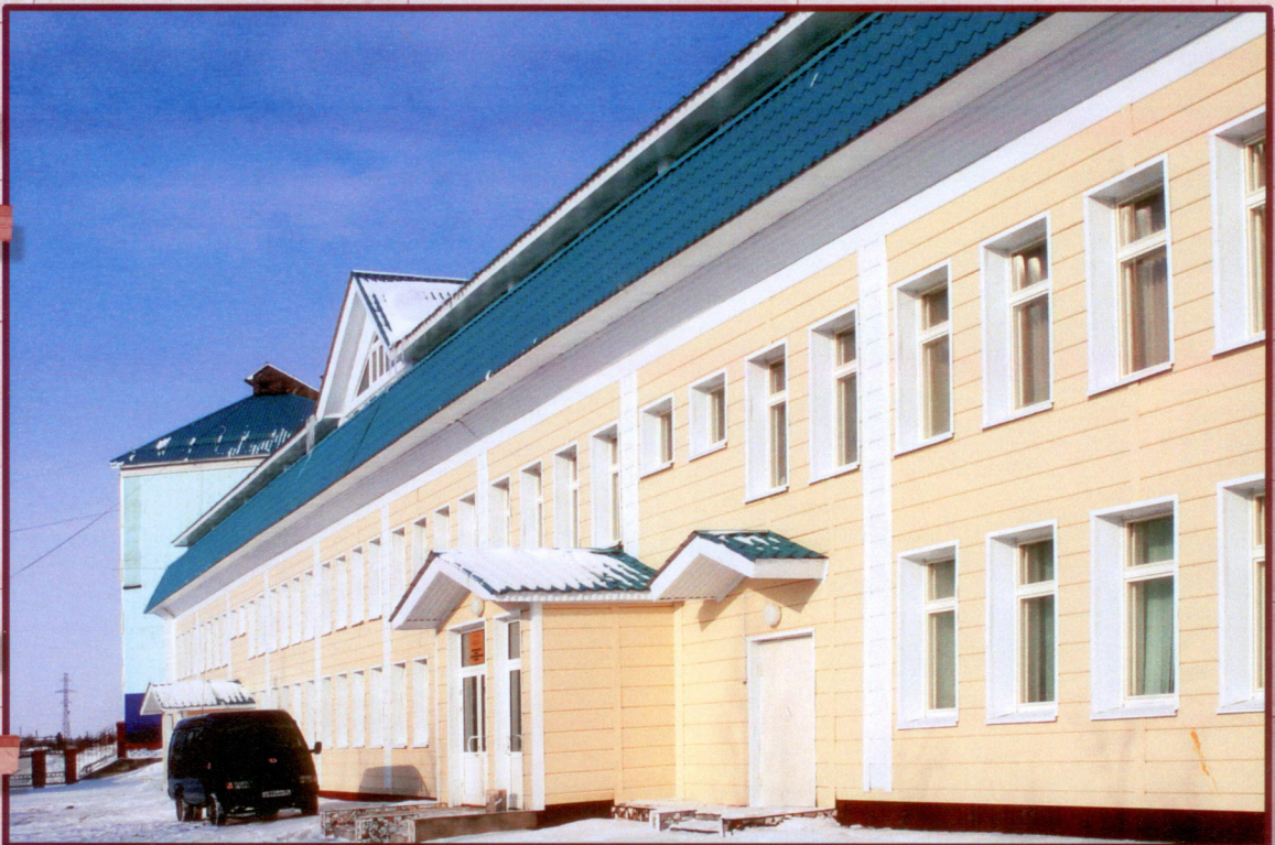
Реконструкция здания поликлиники под психонаркологическое отделение г. Мегион, ул. Садовая, д. 3 Сдано 28.02.2004 г.
