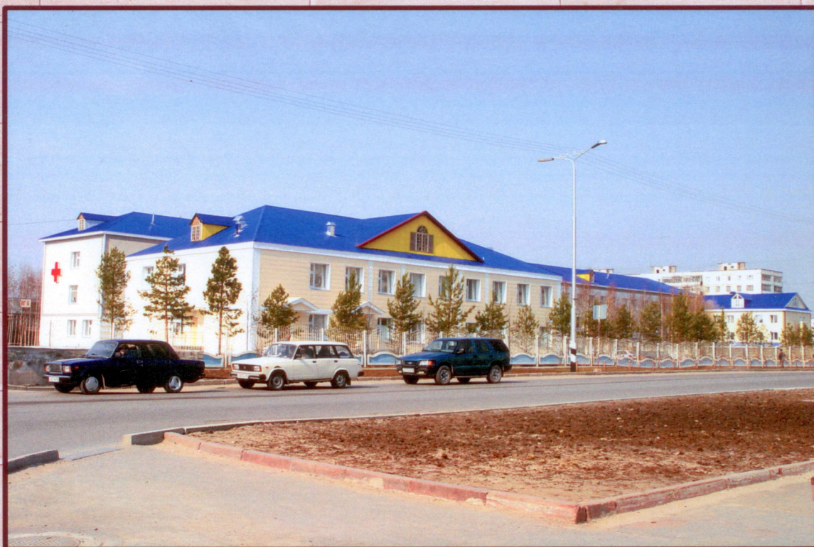
Капитальный ремонт роддома г. Мегион, ул. Заречная Сдан 25.12.2003 г.
