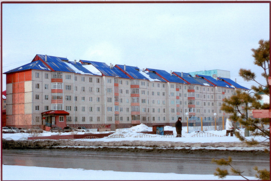
Жилой дом № 5 в 7 мкр. г. Мегион, ул. Заречная, д. 1 Сдан 25.02.2000 г.
