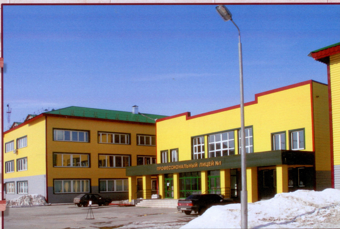
ПТУ на 500 учащихся (Блок А1, КНС) г. Мегион, ул. Кузьмина Сдано 30.12.2002 г.
