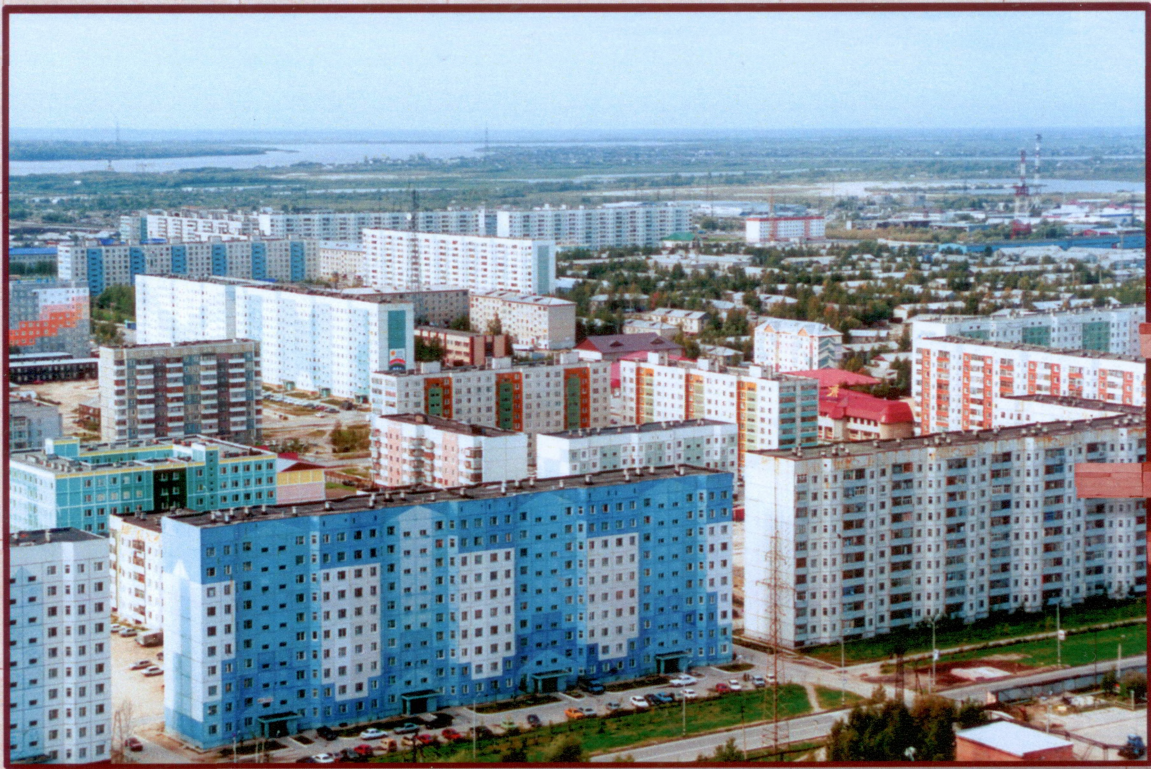
Жилой дом № 19 в 9 мкр. г. Мегион, ул. Кузьмина, д.10 Сдан 01.12.1997 г.
