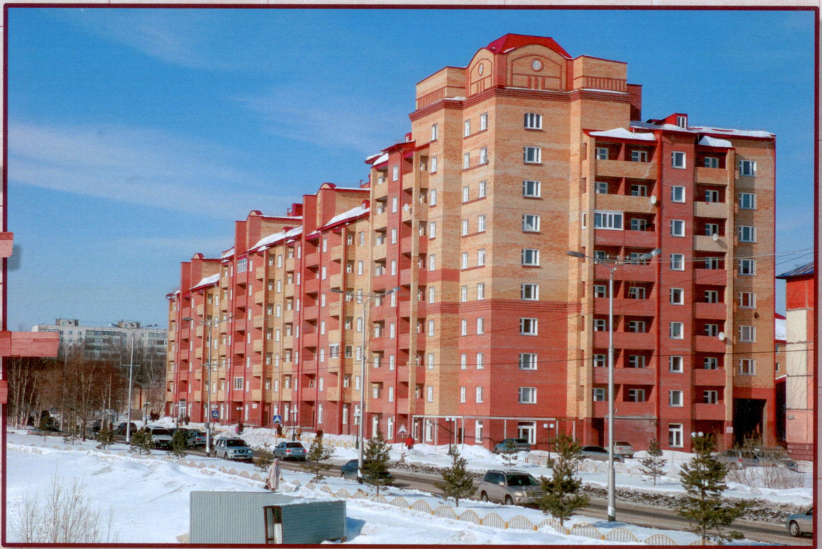
6-9-ти этажный жилой дом с магазинами в 1 этаже г. Мегион, ул. Заречная Сдан 29.12.2009 г.
