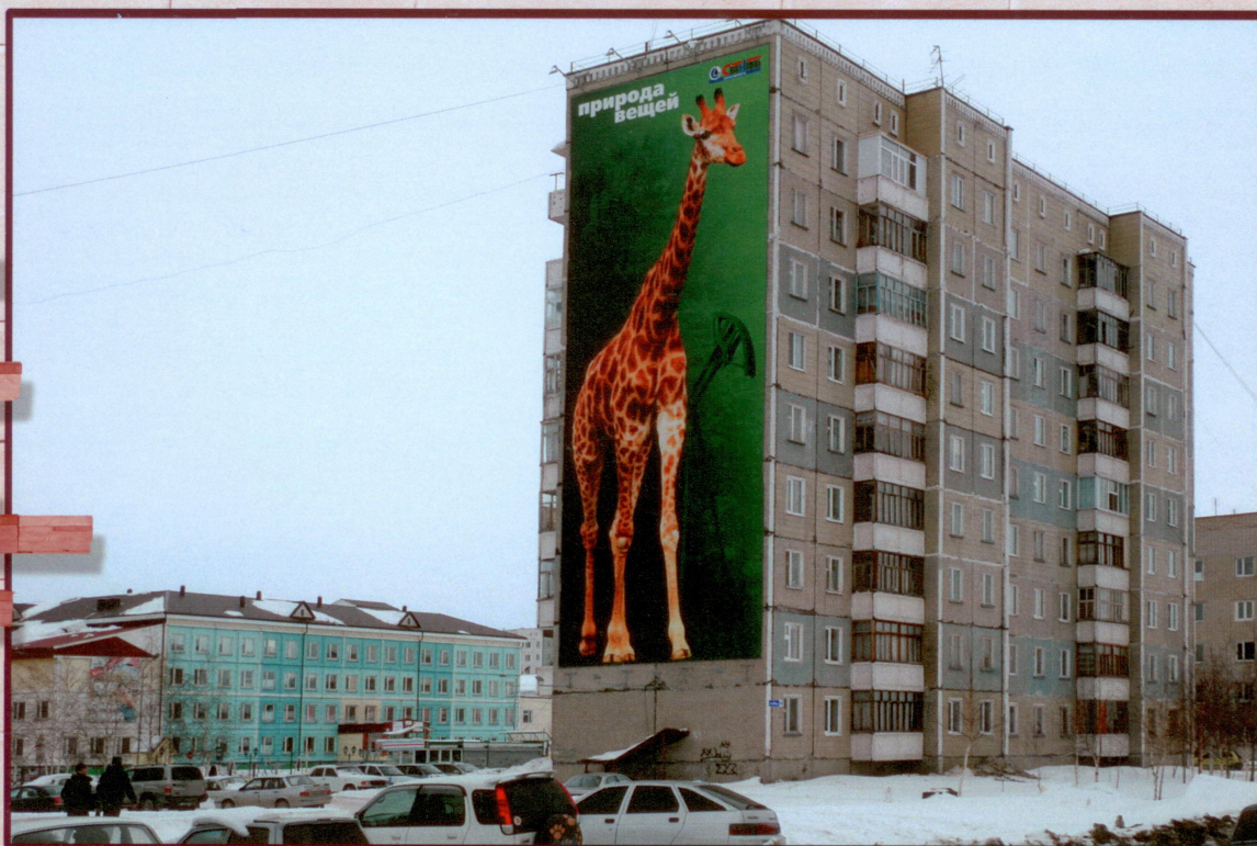
98 кв. жилой дом № 5 в 8 мкр. г. Мегион, ул. 50 лет Октября Сдан 01.02.2000 г.
