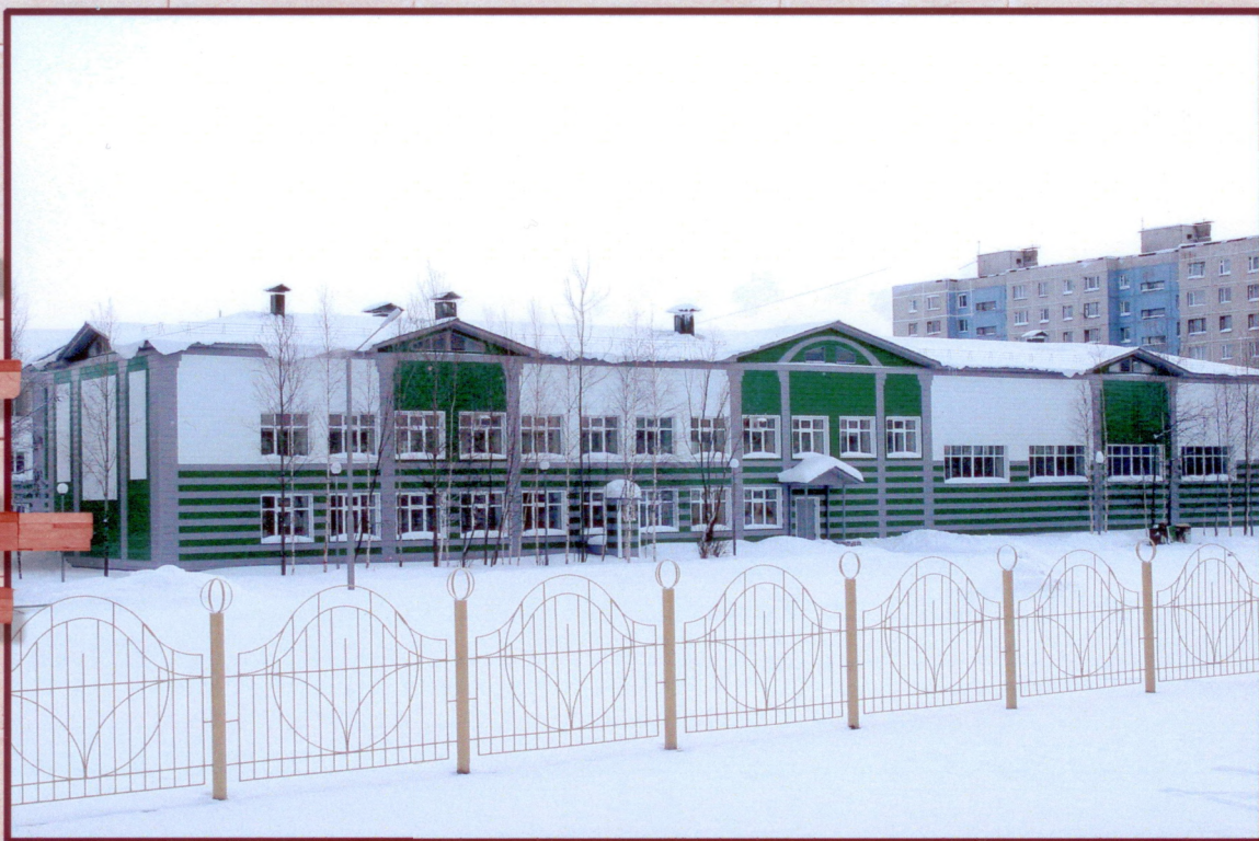
Ремонт МОУ СОШ №3 г. Мегион, ул. Нефтяников Сдана 01.11.2004 г.
