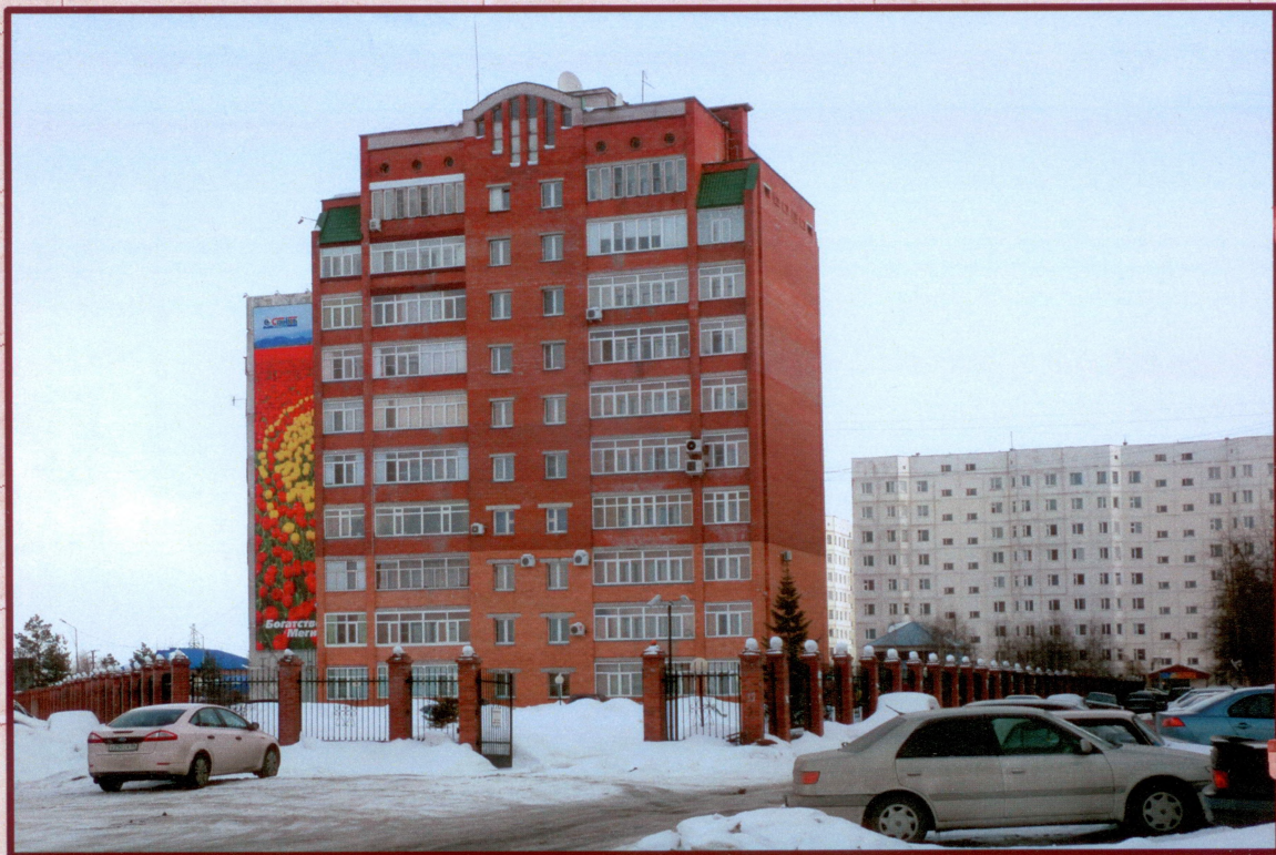
Жилой дом № 3 в 6 мкр. г. Мегион, ул. Кузьмина, д. 30 Сдан 01.12.2000 г.
