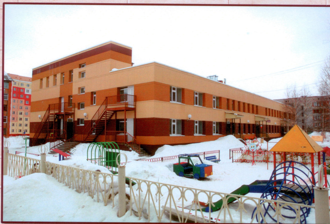
Капитальный ремонт детского сада "Ласточка" г. Мегион, Театральный проезд Сдан 27.12.2007 г.
