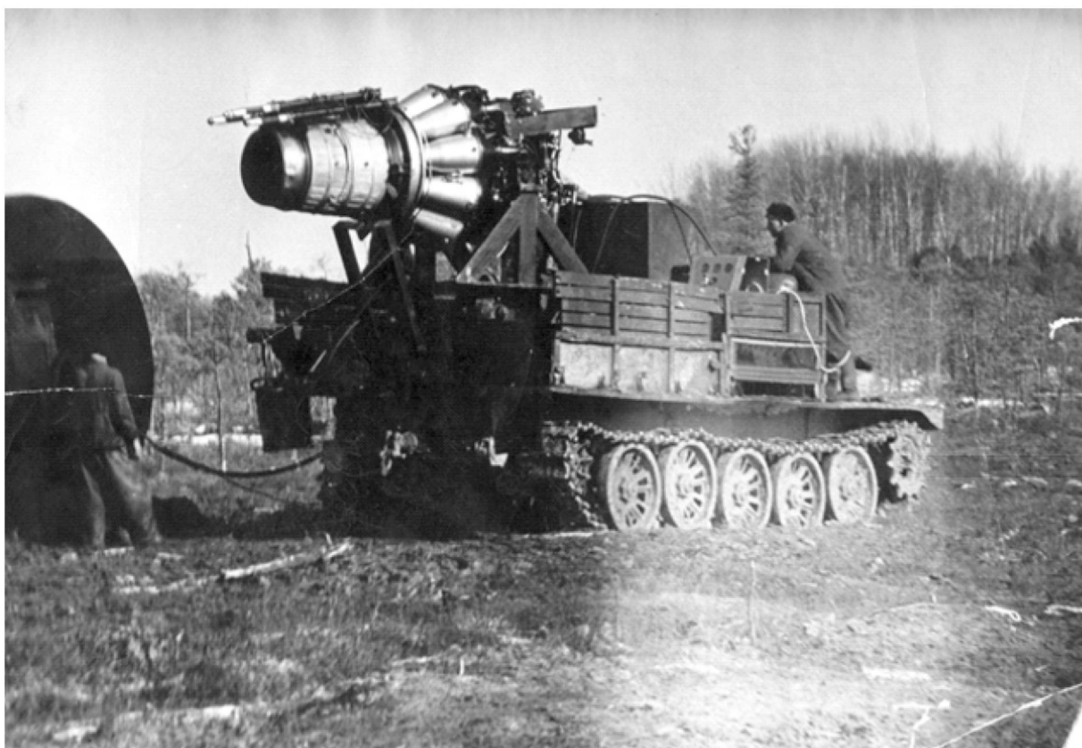
1972 г. Реактивная пушка для укрощения нефтяного фонтана на скважине Р-6 Варьеганской площади
