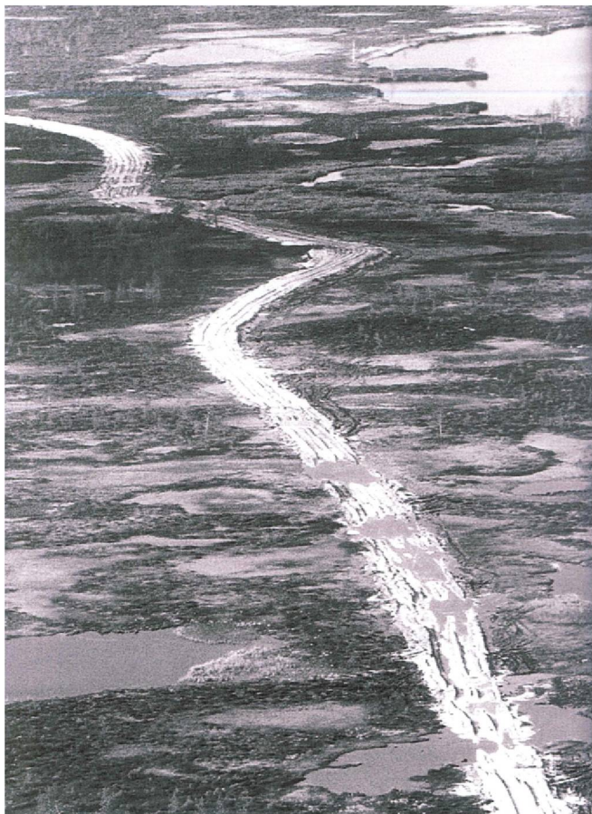
Весна 1965 г. Первая зимняя дорога - лежнёвка на Р-1 Самотлор.
